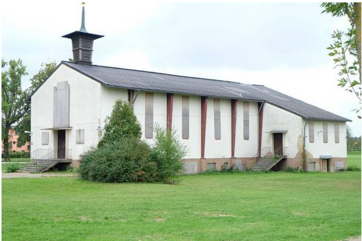
Auch auf dem Gelände der ehemaligen Sheridan-Kaserne: die 1953 als standardisierter Bau in Brettschichtholz-Rahmenbauweise entstandene amerikanische Kirche, die als Denkmal erhalten werden soll. Sie ist allerdings sanierungsbedürftig.
